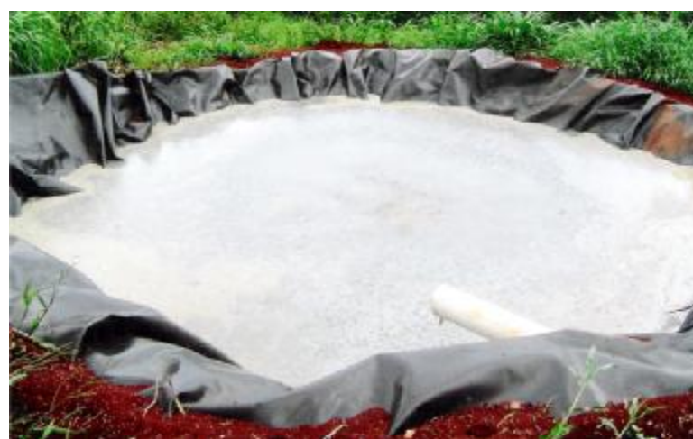
Armazenagem de dejetos em esterqueira
