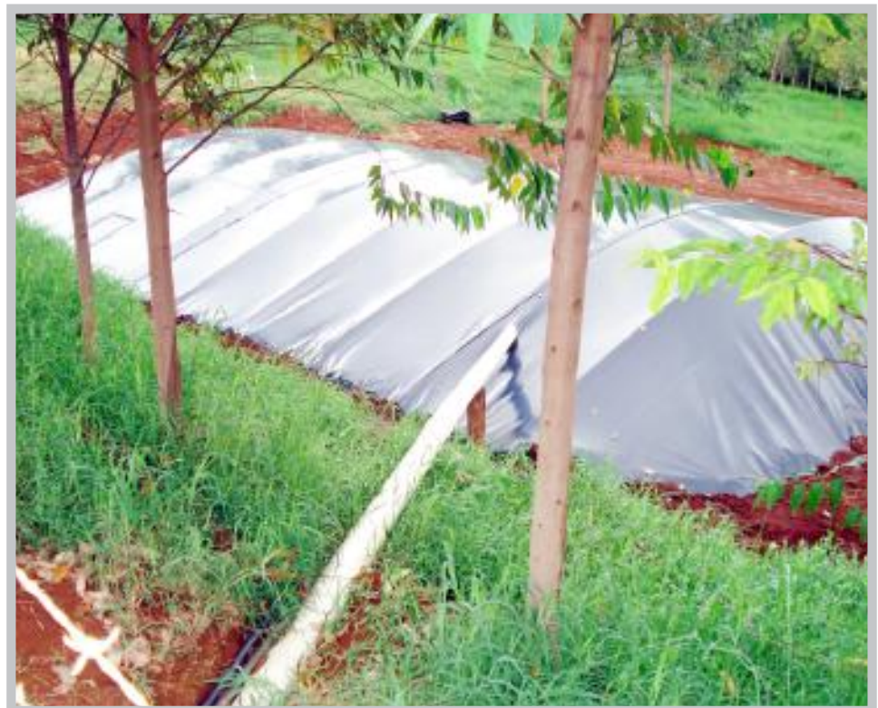
UMA das formas de armazenagem da água – reservatório escavado e revestido com manta de polietileno de alta densidade
