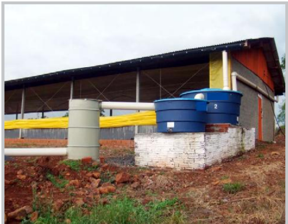
VISTA panorâmica de um sistema de captação e filtragem da água da chuva em uma instalação rural
