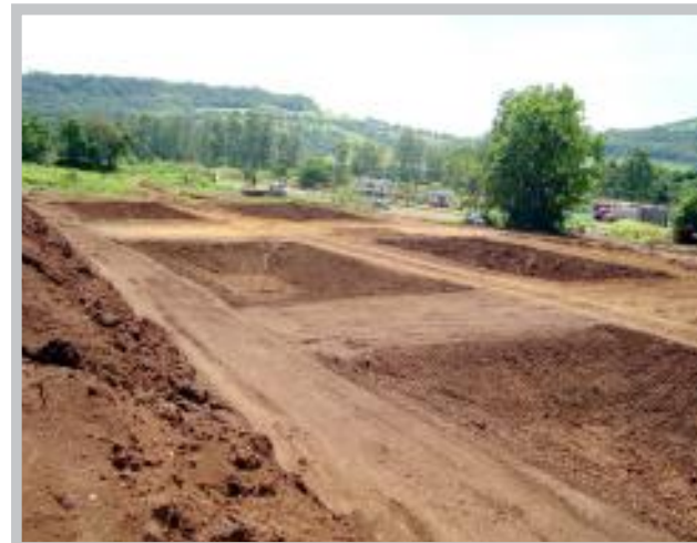
CONSTRUÇÃO dos viveiros experimentais - Águas de Chapecó
