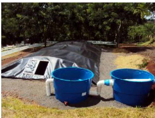
Captação e armazenagem da água da chuva
