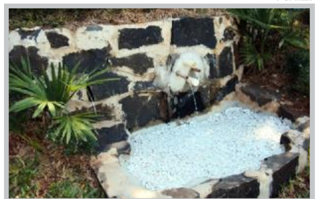
Proteção de fonte de água modelo Caxambu
