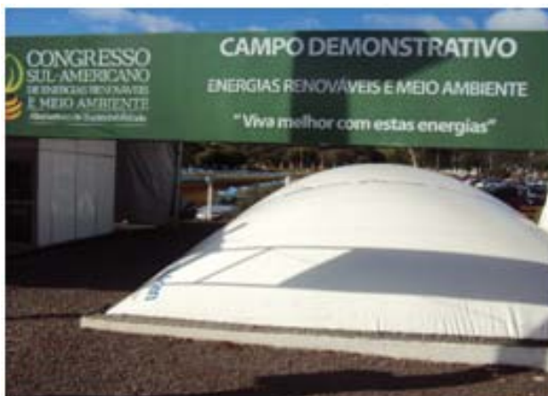
Produção de gás metano através da fermentação de biomassa (dejetos suínos) com um motor de combustão que utiliza este gás como combustível para seu funcionamento.
