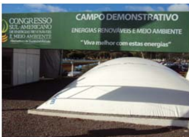
Produção de gás metano através da fermentação de biomassa (dejetos suínos) com um motor de combustão que utiliza este gás como combustível para seu funcionamento.
